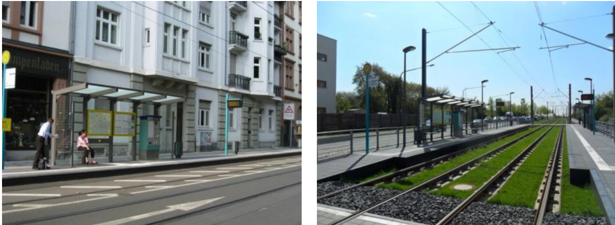
Straßenbündiger Bahnkörper an der Haltestelle „Börneplatz/Stoltzstraße“ (links), besonderer Bahnkörper an der Haltestelle „Alkmenestraße“ (rechts)
