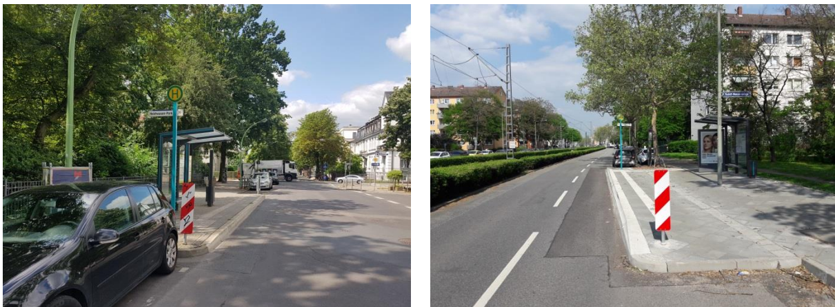
Barrierefreie Haltestellen (Kaps) „Holzhausen-Park“ (links) und „Melibocusstraße“ (rechts)
