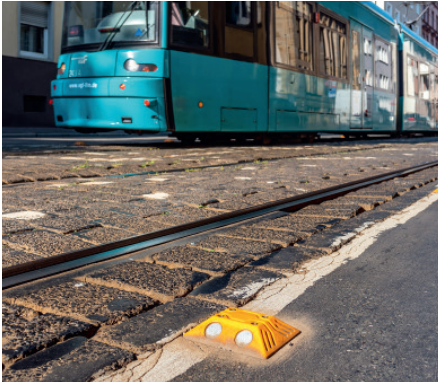
Abb. 3: Markierungsnägel in der Gartenstraße in beiden Fahrrichtungen.
